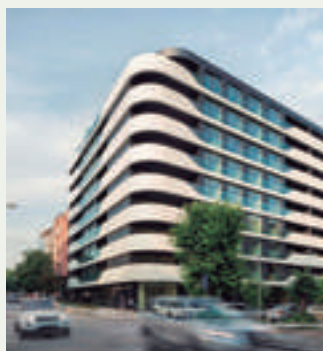
Különleges lakóépület Bulgáriában, hatékony épületgépészeti megoldással. Aquarea
